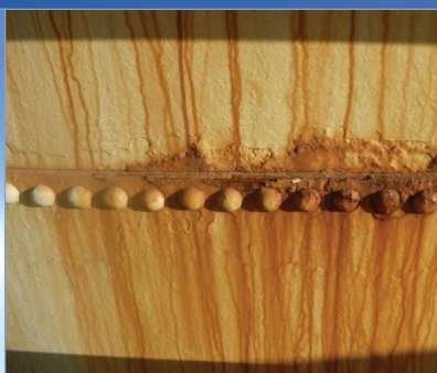
CORROSIÓN INTERNA
