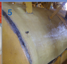
Instalación de parches de Kevlar® con resina 3X
