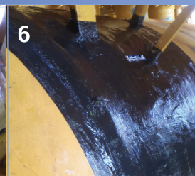
Protección final y etiqueta de trazabilidad
