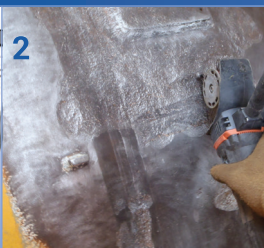
Preparación superficial Sa2½ / St3 y rugosidad Rz > 60 µm
